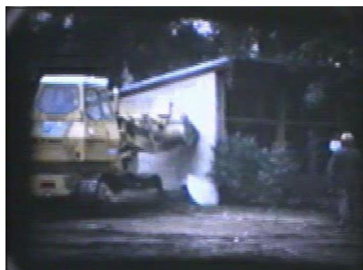
Abriss des Clubhauses in der Scharnweberstraße, Dez. 1975
